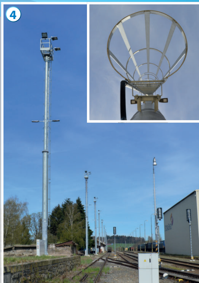
① sklopný stožár ② kamerový stožár ③ přechodové osvětlení ④ osvětlovací železniční stožáry III. větrová oblast ⑤ kamerový stožár
