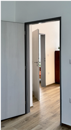
Zárubeň ZAKO® typu YH pro zdění
